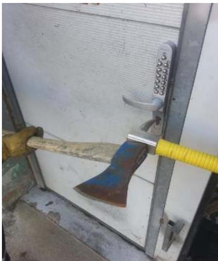
Placer la pointe sur le verrou puis frapper au coup par coup jusqu'à éjection de celui-ci.
