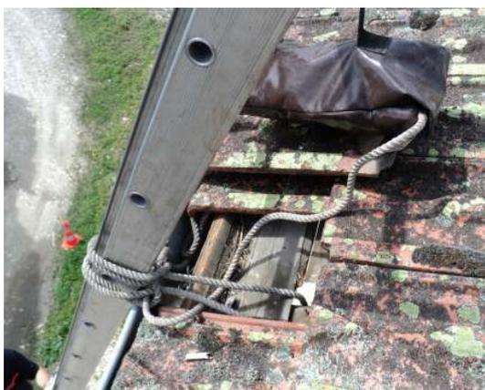
Lors d'une reconnaissance pour un feu, **éviter d'installer une échelle face à un ouvrant en cas de survenu d'un phénomène thermique, privilégier le positionnement sur le côté de l'ouvrant.**(sauf cas particulier : voir « position de l'échelle en itinéraire de secours »)
