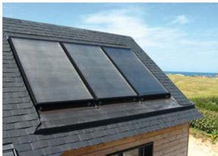
Ils sont composés de surfaces vitrées, reconnaissables grâce à leur couleur sombre et la présence d'un découpage longitudinal. Un fluide caloporteur permet d'absorber la chaleur du soleil et de chauffer un circuit d'eau.
