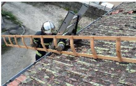
Le premier échelon doit être en appui sur le montant amarré, de l'échelle à coulisse
